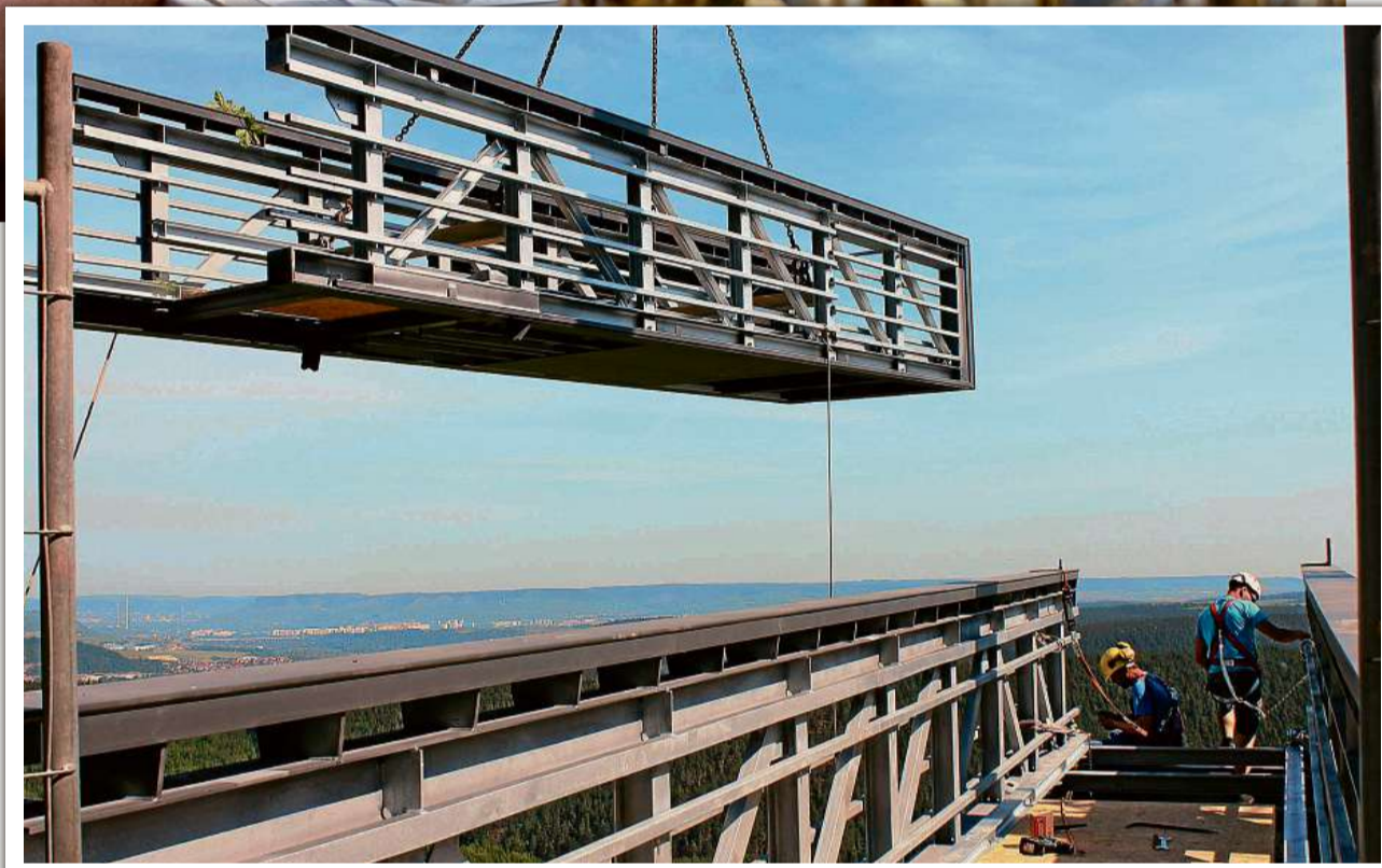
Den imposanten „Skywalk“ an der Leuchtenburg, den Steg der Wünsche des dortigen Porzellanmuseums, hat die Rudolstädter Systembau GmbH. gebaut. Das 15 Tonnen schwere Konstrukt war eine Herausforderung.
